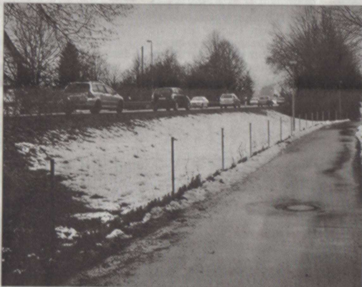
18 000 Autos täglich, 6,5 Millionen Fahrzeuge im Jahr: Eine Lärmschutzwand an der B 388 auf Höhe der Reihenhaussiedlung Erding Ost wäre dringend notwendig. flo/Foto: Bauersachs
